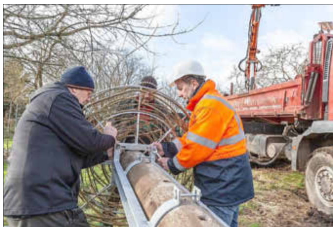
Mitarbeiter der Elektro- und Energieanlagenbau GmbH stellen Betonmast mit der neuen Nisthilfe auf.
