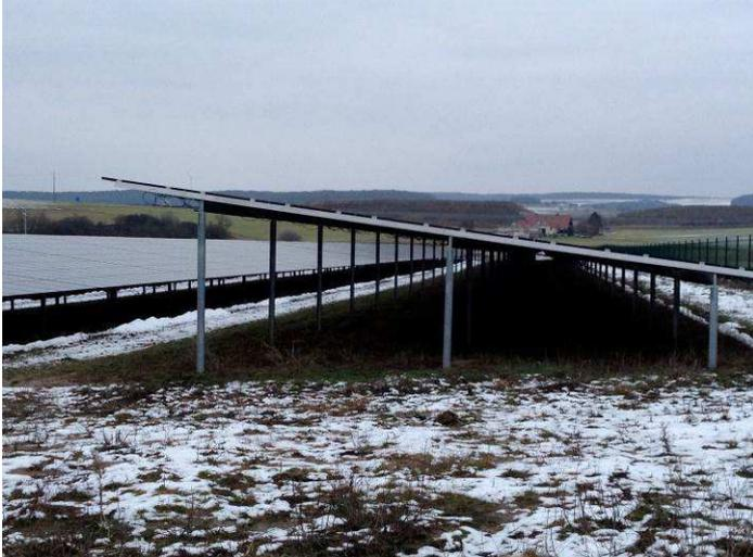
Abbildung 5: Aufgestellter Modultyp „Triple Support“
